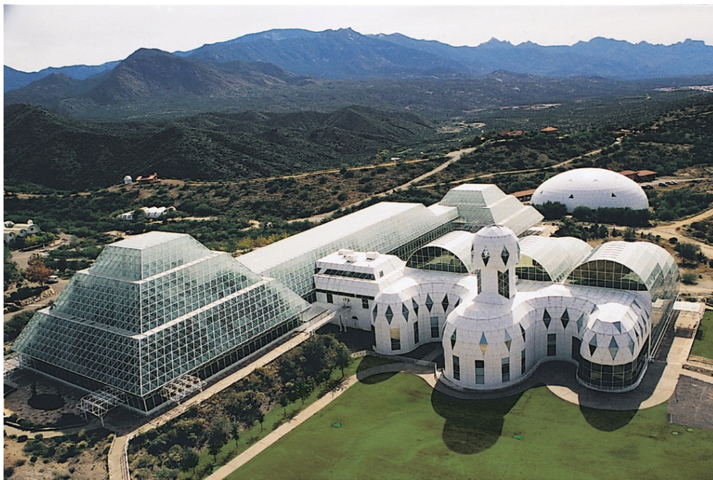
4. ábra. A Bioszféra II épületegyüttese Arizonában
