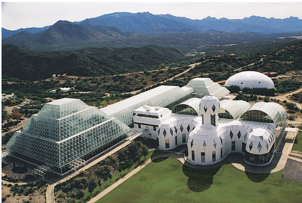
4. ábra. A Bioszféra II épületegyüttese Arizonában
