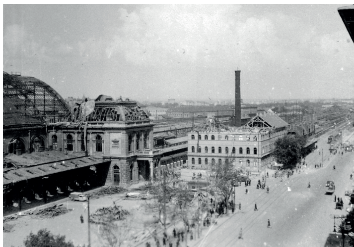
2. kép: A Keleti pályaudvar és a gödöllői HÉV-vonal indóházának sérülései (Forrás: http://www.fortepan.hu/_photo/download/fortepan_7515.jpg utolsó megnyitás: 2015. november 29.)
